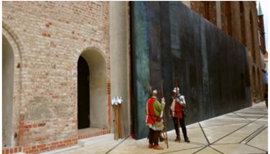
Blick auf die Bronze-Schutzverkleidung für die erhaltenen Fresken der Klosterkirche (Kirchplatz)
